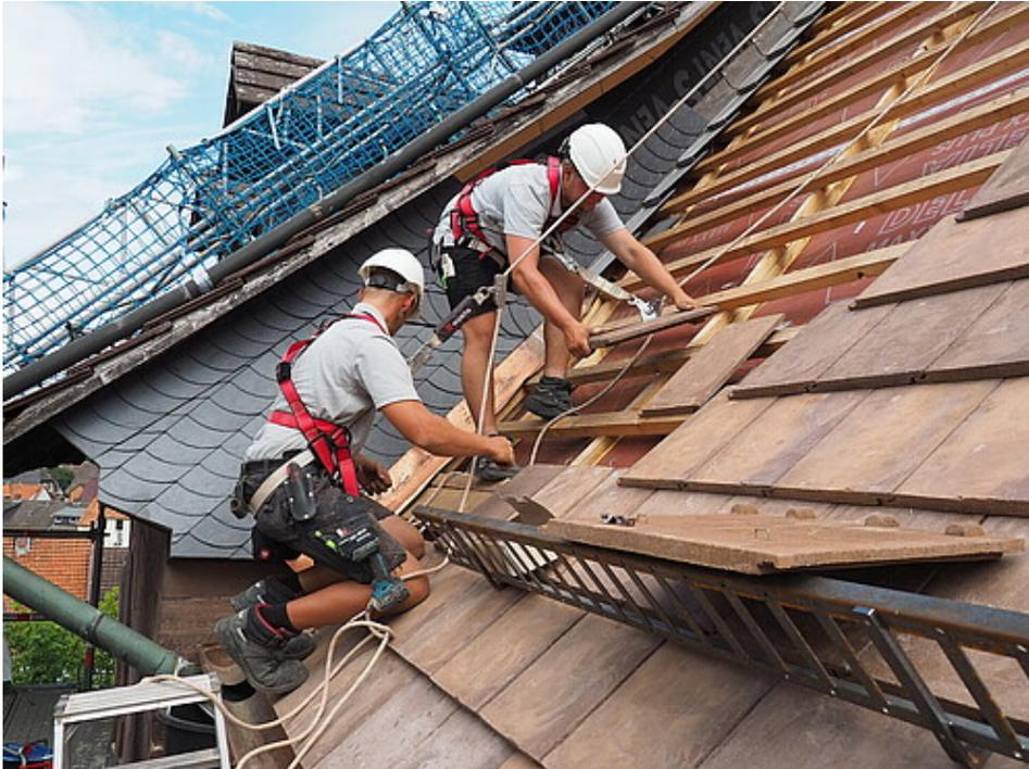
Dachdecker verlegen eigens entwickelte Dachplatten auf dem Süddach der Münsterkirche St. Alexandri in Einbeck. Foto: Klosterkammer/Dorothee Räber
