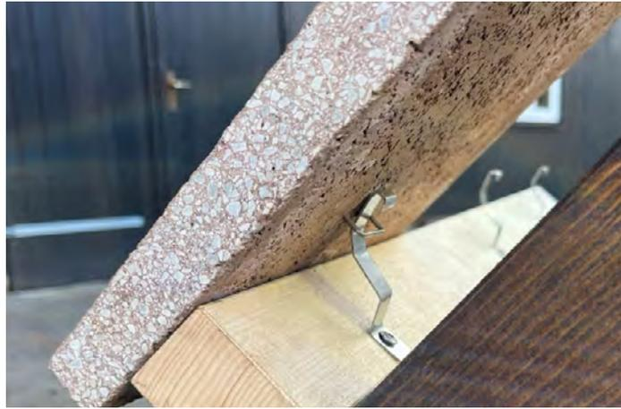
Beim Einhängen muss die Platte auf der Latte bzw. auf der Platte aufliegen und nach unten geschoben werden.
