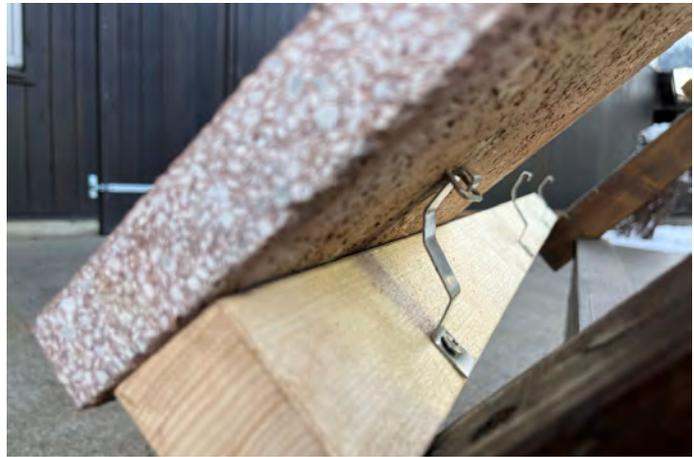
Bei Plattentausch wird sie ohne Anhebung nach oben geschoben.
