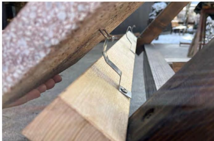
Bei Angriff durch Wind hebt sich die Platte und hängt sich automatisch an der Windsogklammer ein.
