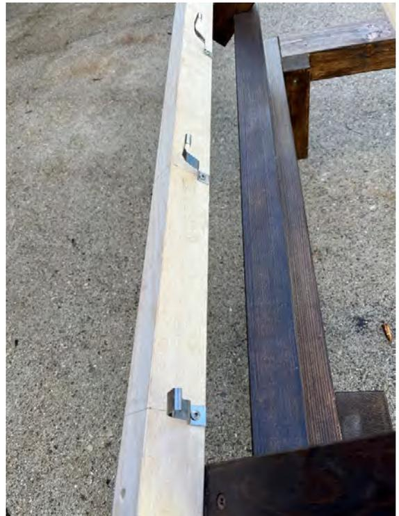
Die Windsogklammern werden an der Traufenlatte gemäß Windsogmaß befestigt.
